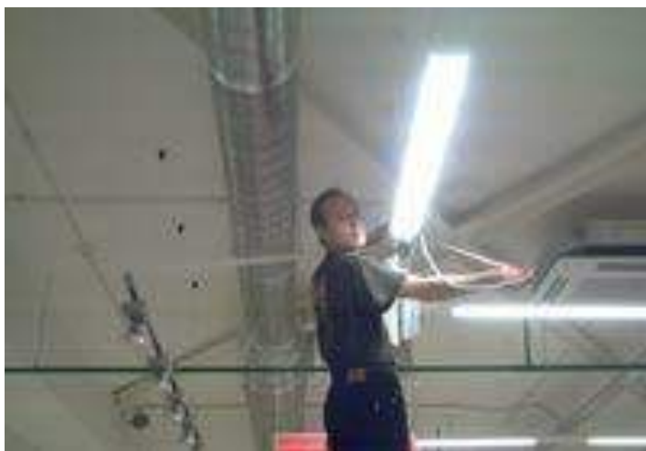
Рисунок 3 Монтаж дежурного освещения
